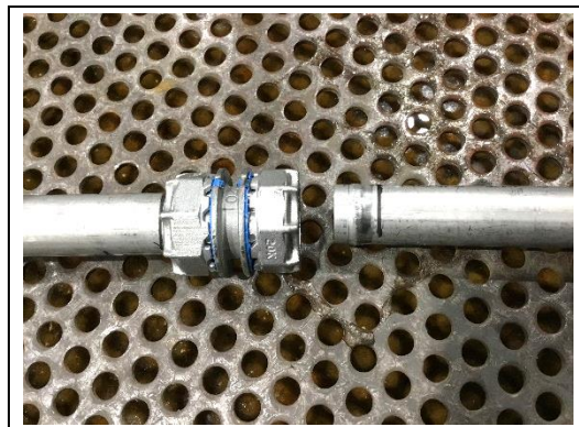
写真 4-12 破壊水圧試験(試験後)
