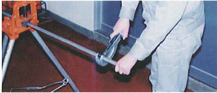
写真-2 ロータリーチューブカッターを用いた管の切断
