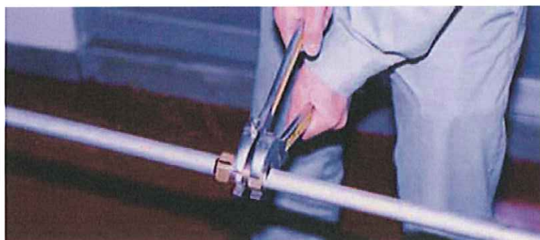
写真-5 袋ナットの本締め
