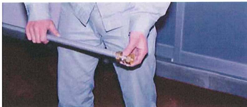
写真-3 継手への管の差し込み
