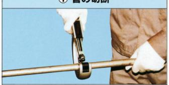
ロータリーチューブカッターまたは弓のこを用いて、管 軸線に直角に切断してください。
