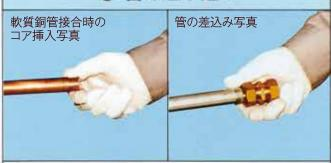
袋ナット、スリーブを組立てたままの状態で、管を継手内部の段部(ストッパー)に突き当たるまで差し込んでください。スムーズに差し込めない場合は、以下の理由が考えられますので、次の通り行なってください。
