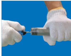
管の鉄地が露出するような面取は避けてください。また、バーリングリーマーを使用する場合、ライニングを損傷させる恐れがありますので注意して作業してください。
