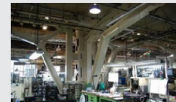
建屋の耐震補強(震度6強で倒壊しない)
