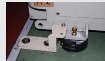
設備のアンカー固定(防振ゴム併用)
