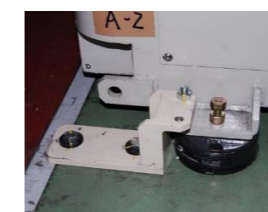
設備のアンカー固定 (防振ゴム併用)
