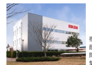
複数の旧建屋から耐震新棟へ 間接部門を移転・集約化
