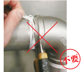
ZD SUS継手の断面(写真) ねじ奥にシール剤を塗布しないことで 端材の混入を防止、 接続部の緩み防止に効果あり
